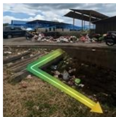
Gambar 2. Timbunan Sampah di Saluran Drainase
