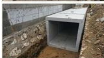
Gambar 3. Box Culvert di Depan Pertokoan Saga Kemiri (Sumber: Dok. Lapangan, 2026)
